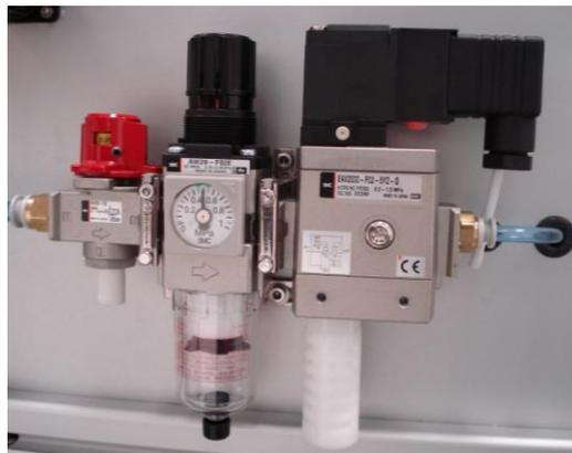
Figura 82 Válvula de pressão e filtro de entrada de ar da célula
