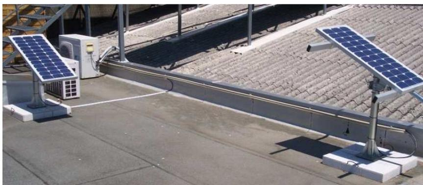
Figura 4.34 – Painel fotovoltaico fixo (à esquerda) e painel fotovoltaico com seguidor solar (à direita).
