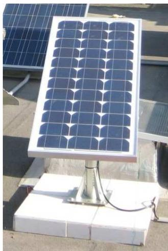
Figura 4.31 – Base em cimento para fixar os painéis fotovoltaicos.
