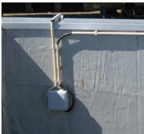
Figura 4.36 – Caixa de derivação ligada a 230 V CA.
