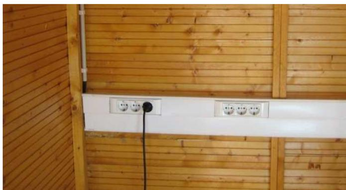
Figura 4.38 – Instalação das tomadas.
