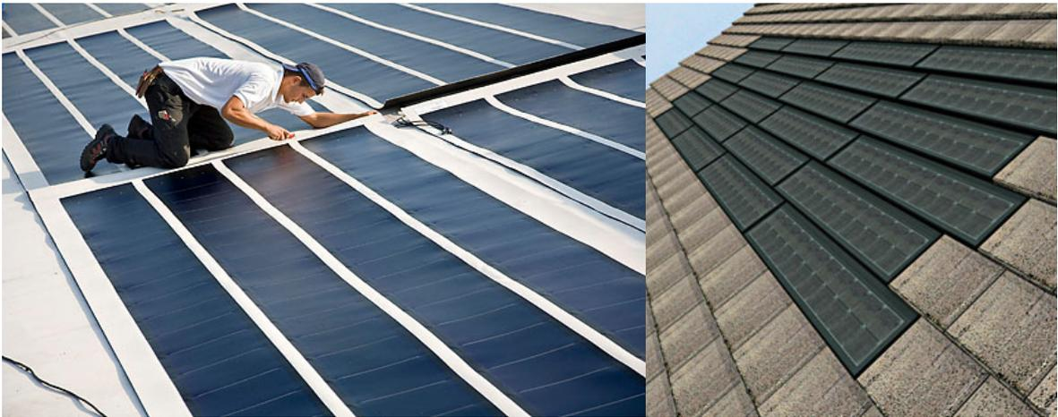
Figura 2-9 Aplicação de painéis de silício amorfo [26]
