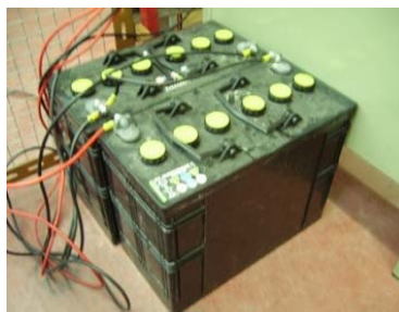
Figura 4.6 – Baterias de 12V ligadas em série.
